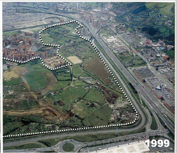
1999an Castaños ibaia kanalizatua zegoen, A-8 eta Max Center eraikita eta geratzen zen berde gunean hasia ziren inausketak MegaPark eta etxe dorreak eraikitzeko.
